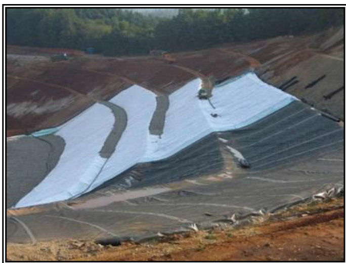
Slika 3. Postavljanje kombinovanih geosintetičkih materijala
